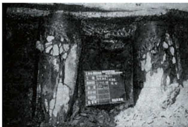
写真-2 杭の被害写真 (志賀敏夫 1980)
