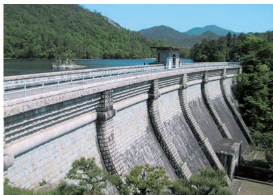
写真5 100年以上の雄姿を残す本庄水源地堰堤 (旧海軍が1918年に建設した呉市に所在する重力式ダム)
