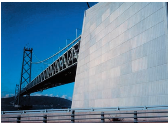
写真3 明石海峡大橋の1Aアンカレイジ （低発熱性のセメントを活用したマスコンクリート構造物）
