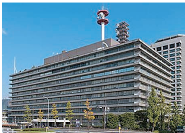
国土交通省本省庁舎（中央合同庁舎第3号館）
