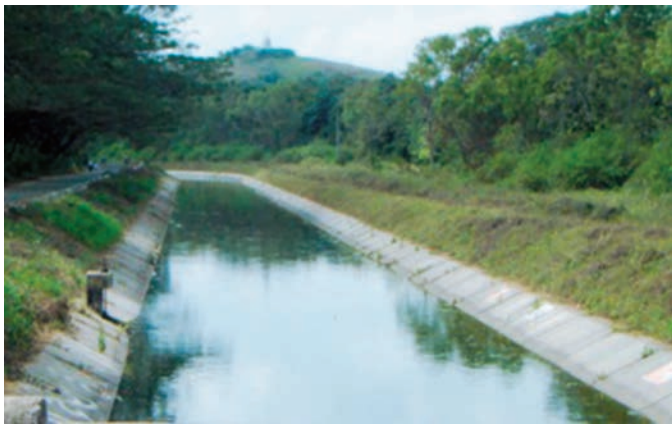
全線コンクリート張りとなった灌漑用水路法面
