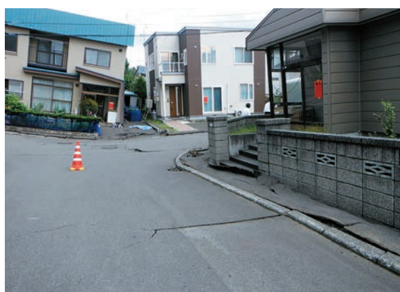
写真5 札幌の盛土造成地の陥没
