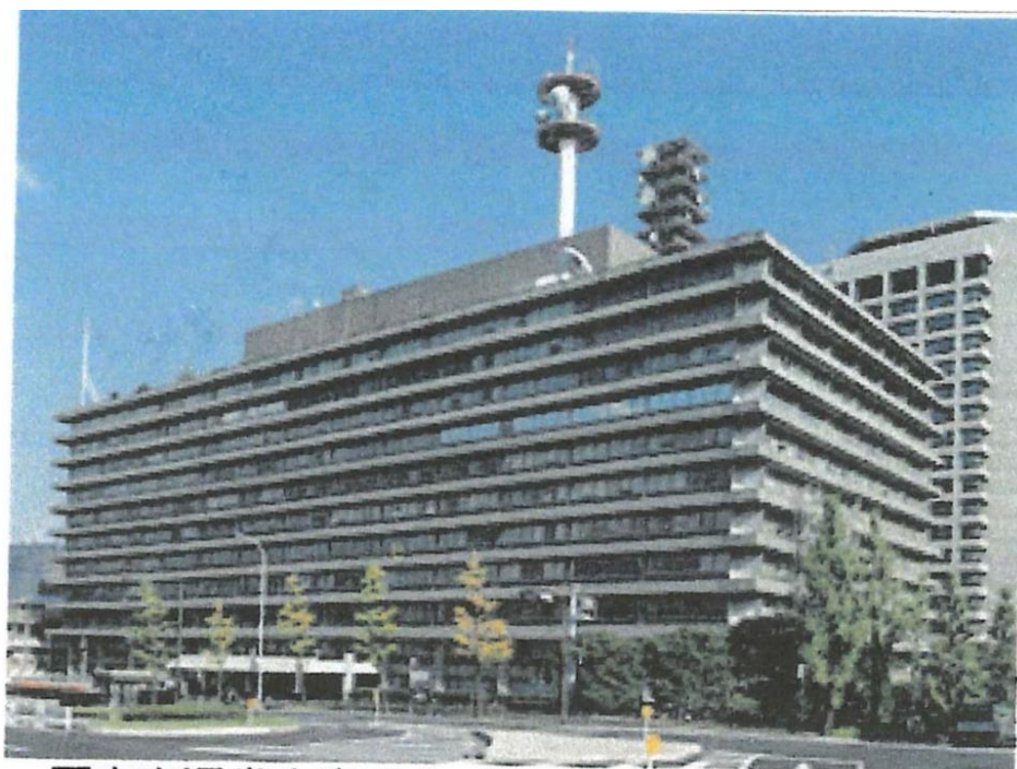
国土交通省本省庁舎 (中央合同庁舎第3号館)
