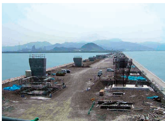
写真4 新北九州空港連絡橋の橋脚を建設している風景
