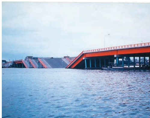
写真2 新潟地震で落橋した昭和大橋(渡辺隆博士撮影)
