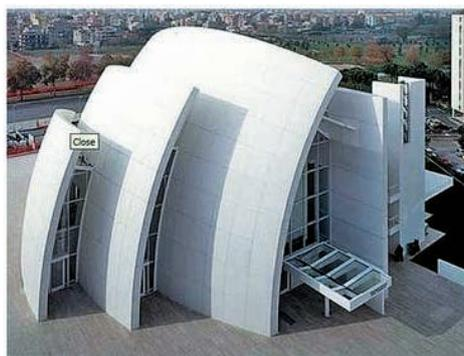
図4. Italcementi 社製の酸化チタン光触媒含有セメントで施工されたイタリアの Jubilee 協会
