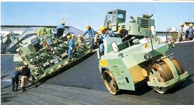
写真-10 傾斜面舗装システム
