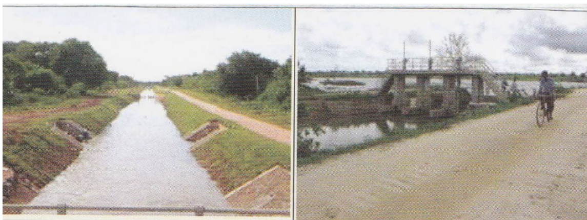
張り芝の法面水路(左)と渡橋部のコンクリート法張り部(右)
